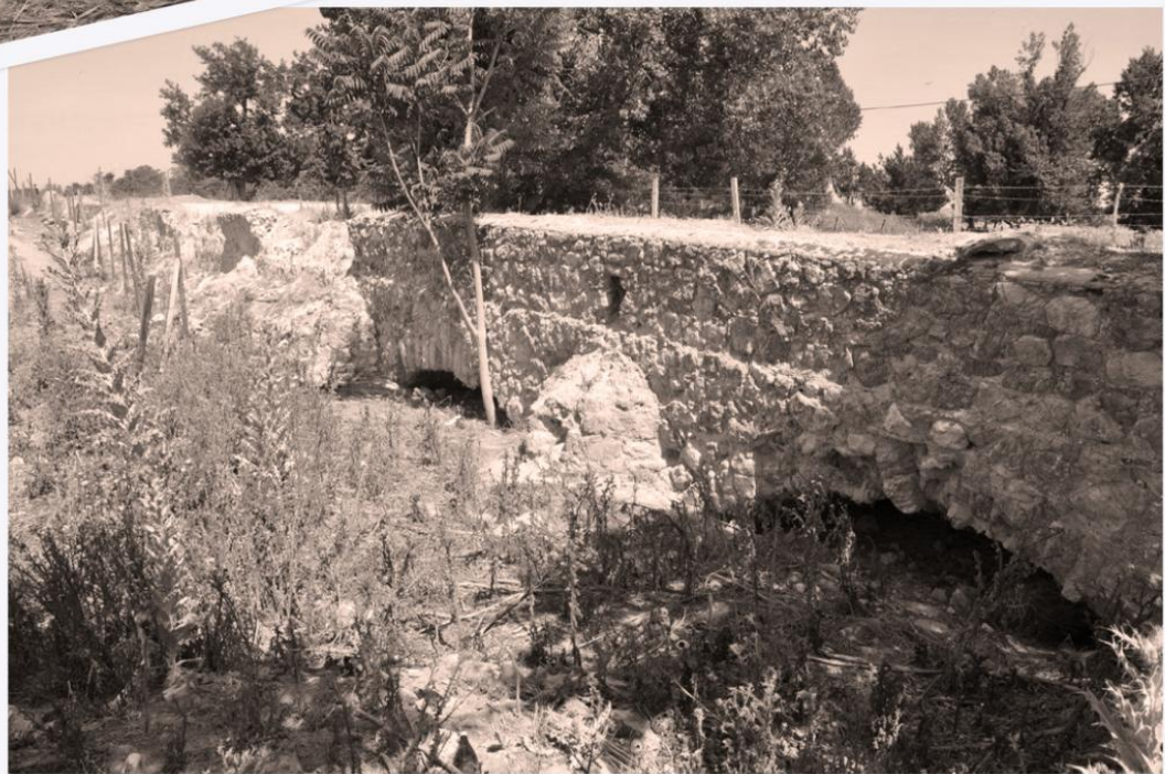
Puente de La Aldehuela.
